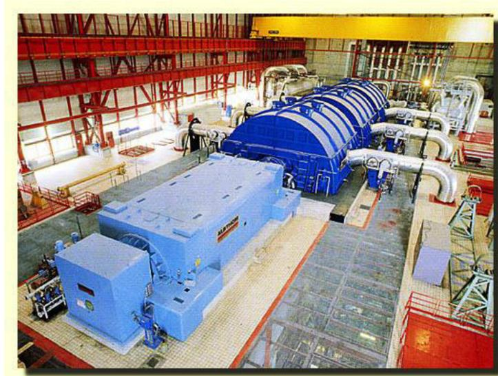
**Figure 37-06 :** Exemple d'alternateur de forte puissance (partie bleue claire du Groupe turbo-alternateur) 1300 MW - 1500 /min - 50 Hz triphasé au premier plan la partie excitation et réglage de puissance
