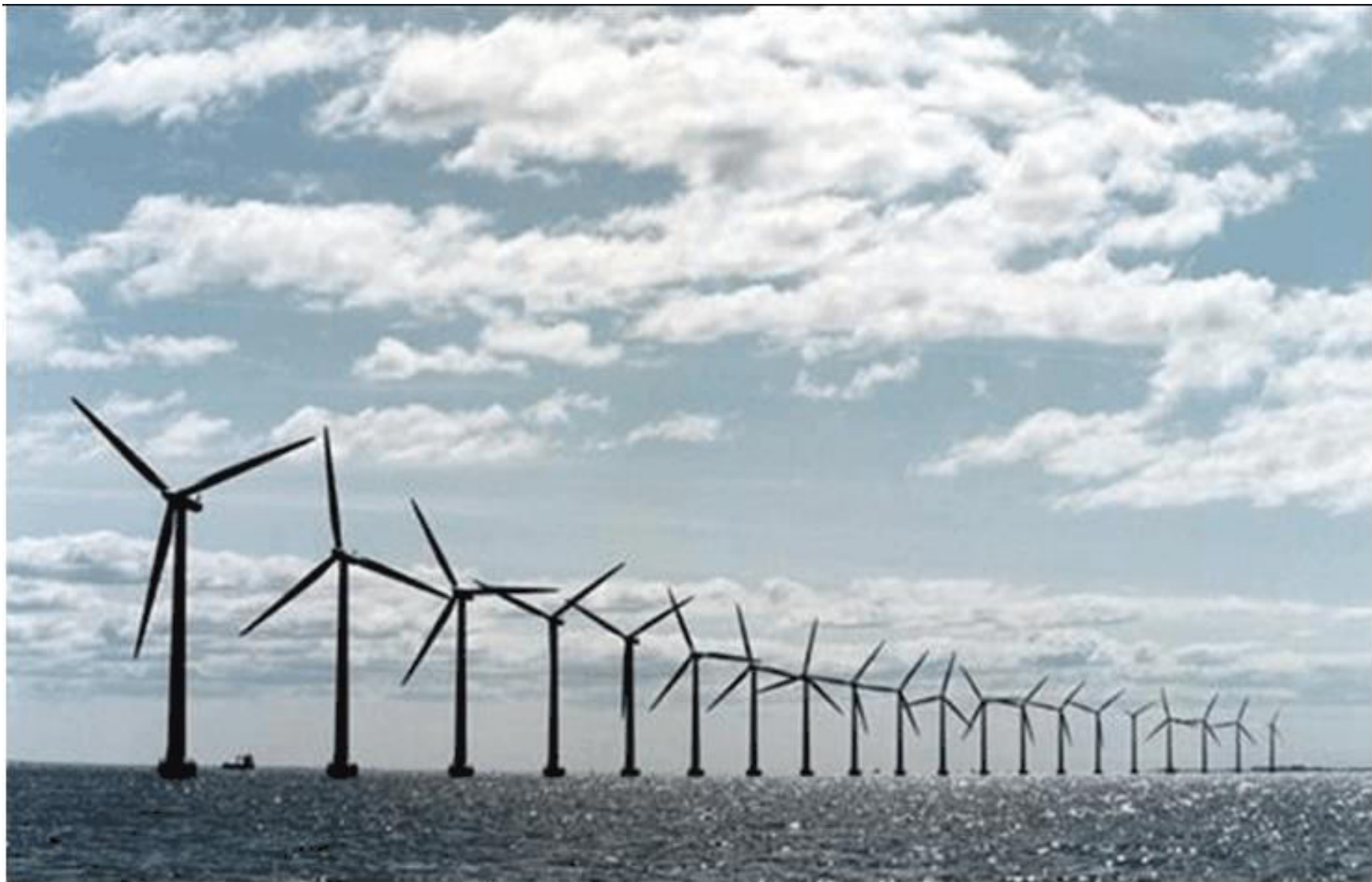
Parc d'éoliennes à Zeebrugge
