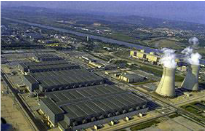
Usine de Pierrelatte (Drôme, France)
